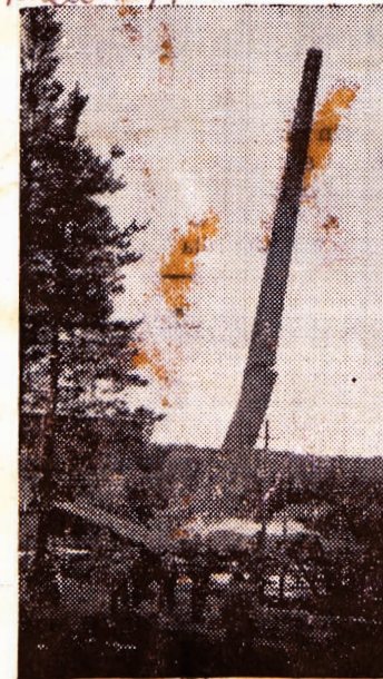
Valokuvaajan täysosuma. Mätäsvaaran voimalaitoksen savupiippu kaatuu.
