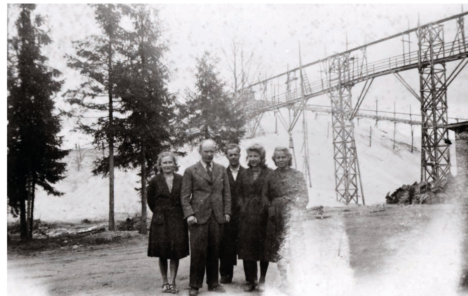
Rikastamolaboratorion henkilökuntaa. Takana näkyy puurakenteita, joiden avulla rikastusprosessissa syntyynyttä kvartsipitoista hiekkaa kuljetettiin läheiselle lammelle, joka täyttyi kokonaan jättehiekasta. Rikastamo ei ole säilynyt, mutta hiekkadyynit ovat yhä nähtävissä.
